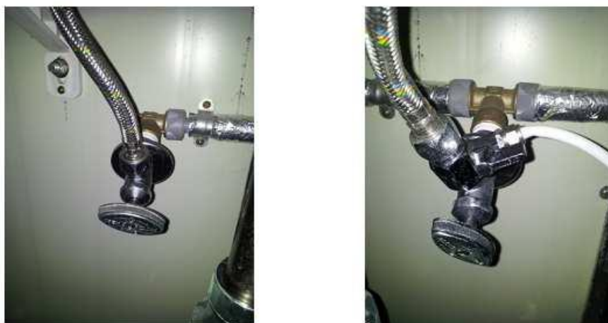
Рис. 5. Установка водопроводного крана в другом варианте (без подключения к мойке)
