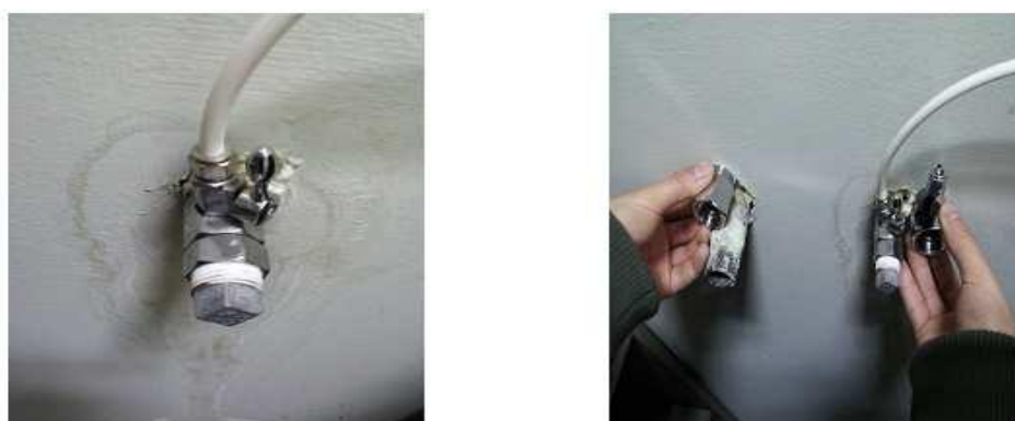
Рис. 5. Установка водопроводного крана в другом варианте (без подключения к мойке)
